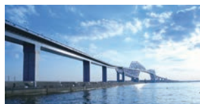
東京ゲートブリッジ
