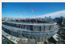
建設進む新国立競技場「杜のスタジアム」 (東京都新宿区) 提供:日本スポーツ振興センター
