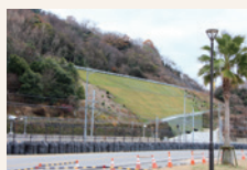
「西日本豪雨の被害から復旧したクリアライン」(広島県呉市)
