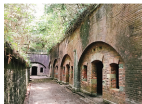
⑥友ヶ島(沖ノ島)にある「第3砲台跡」
