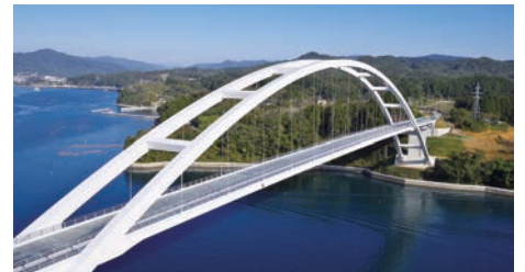
気仙沼大島大橋（愛称：鶴亀大橋）
