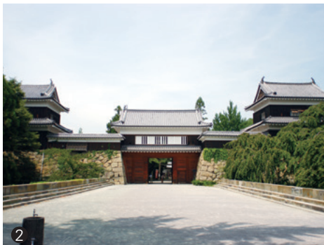
①公園内にある上田城本丸跡 ②上田城跡公園の東虎口櫓門
