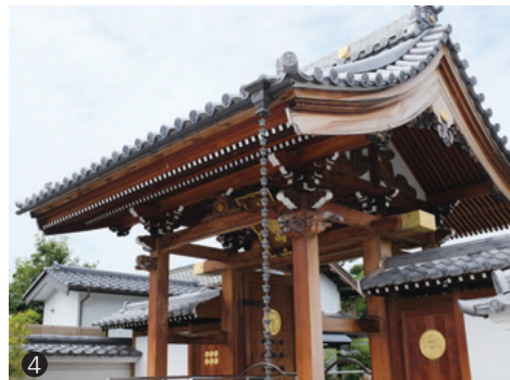
③上田城唯一の現存遺構である西櫓 ④小松姫の墓がある芳泉寺
