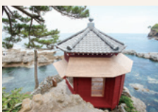
五浦六角堂 (茨城県北茨城市)
