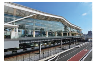
高輪ゲートウェイ駅の外観 提供:JR東日本
