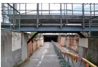
現在のところ、線路を挟んで海側に行くには泉岳寺駅にほど近いこの高輪橋架道橋を通る必要がある。トンネル新設のため、現在は車両通行止め
