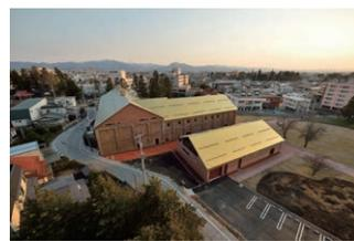
金色に輝く「シードル・ゴールド」の屋根。かつてここで造られていたシードルを思わせる色。正方形のチタン材を約1万3000枚使用した「菱葺（ひしぶき）屋根」になっている ©Naoya Hatakeyama
