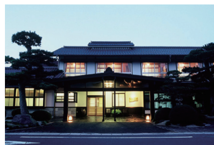
昭和30年代の木造建築物をベースとした本館の外観
