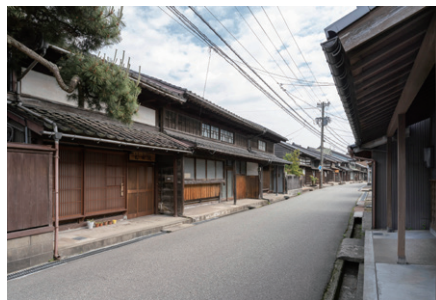
吉久重伝建地区の放生津往來の町並み
