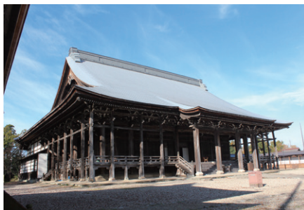
1795年に建立された勝興寺本堂。間口39.4m、奥行37.5mの巨大な木造建築物。長さ最大9mの柱が122本も立っている。平成の大修理では半解体修理が行われた
