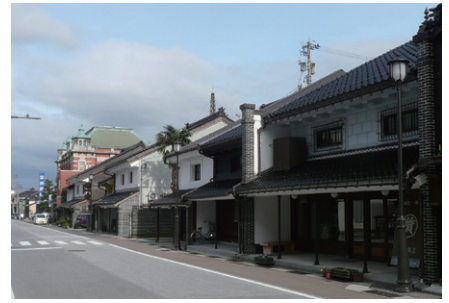
明治時代の優れた防火建築が残る山町筋。土蔵造りの旧家42棟が立ち並ぶ
