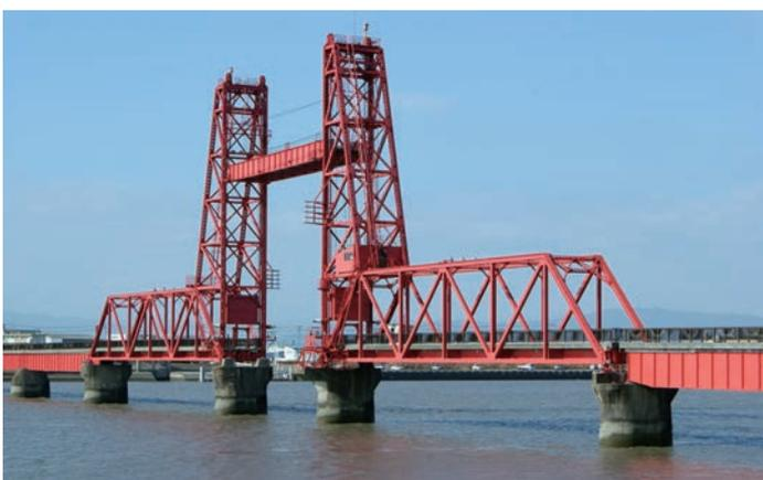
昇開式可動橋「筑後川昇開橋」
