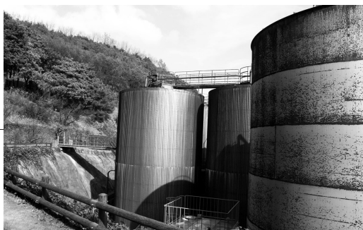
▲巨大な貯蔵タンク
