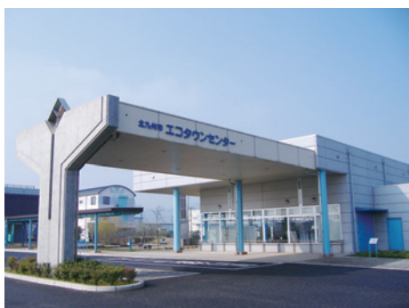
エコタウンの中核施設「北九州市エコタウンセンター」では随時、見学を受け付けている
