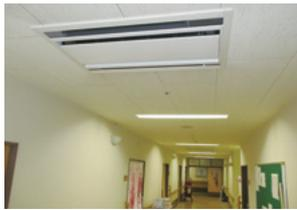
廊下天井部に新たに取り付けられた電気式パッケージエアコン
