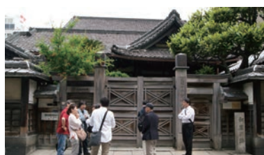
愛珠幼稚園園舎
