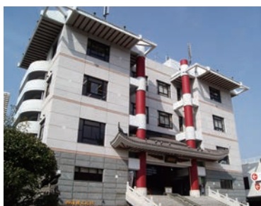
「四海楼」の外観
